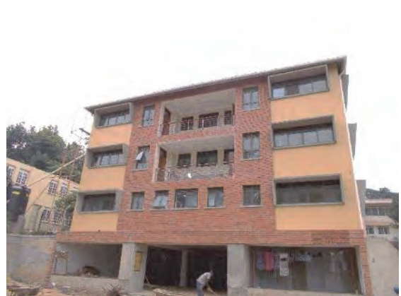
Irish AID により建設中の 中央 INSET 用のホステル
