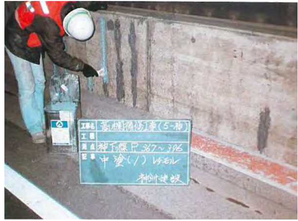
Photo 5.2.9.5 Tack-coating សំរាប់ coat ទី២
