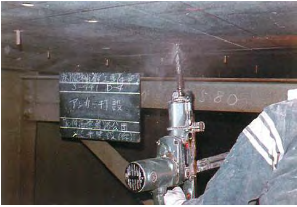
Photo 5.2.7.2 បង្កើតប្រហោងលើ anchor
