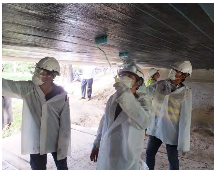
Photo 5.2.2.33 លាបការ impregnating លើកទី២
