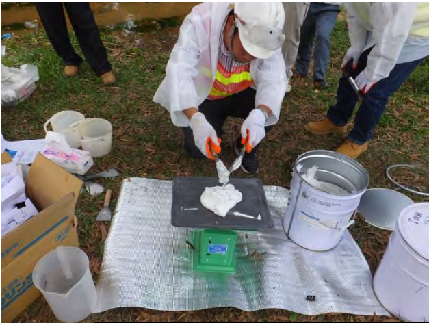
ចំនួន smoothing agent ដែលត្រូវប្រើ 3kg/1 ដង (សារធាតុគោល : សារធាតុបង្កក = 2:1) 1.5kg/m 2 (សារធាតុគោល: សារធាតុបង្កក = 1:0.5) (អាស្រ័យលើអ្នកធ្វើ)
