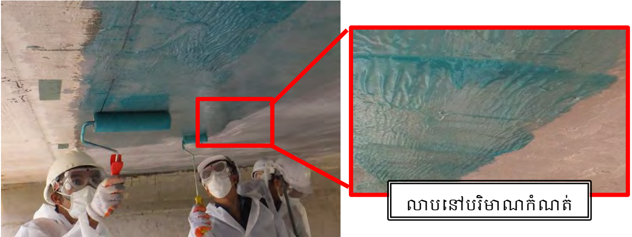
Photo 5.2.2.28 លាបការ impregnating លើកទី
