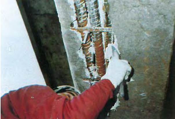
(a) ប្រើប្រាស់ការEpoxyដើម្បីធ្វើការជួសជុល
