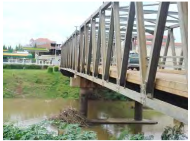
Photo 1.3.7 ស្ពានដែកខ្លែង (Truss bridge)
