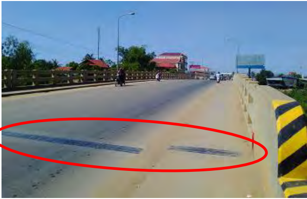
Photo 1.3.11 គន្លាក់ភ្ជាប់ (Expansion joint)
