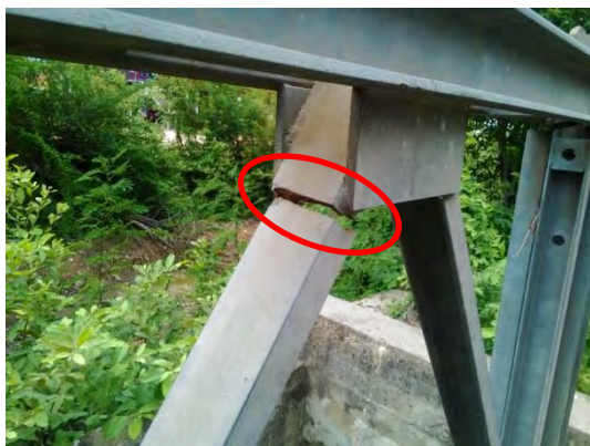
)ង (ការខូចខាតគ្រឿងបង្កើនធ្ងន់ធ្ងរលើផ្ទឹមមេ ឬផ្ទឹមខ្វែង (Fatigue crack)
