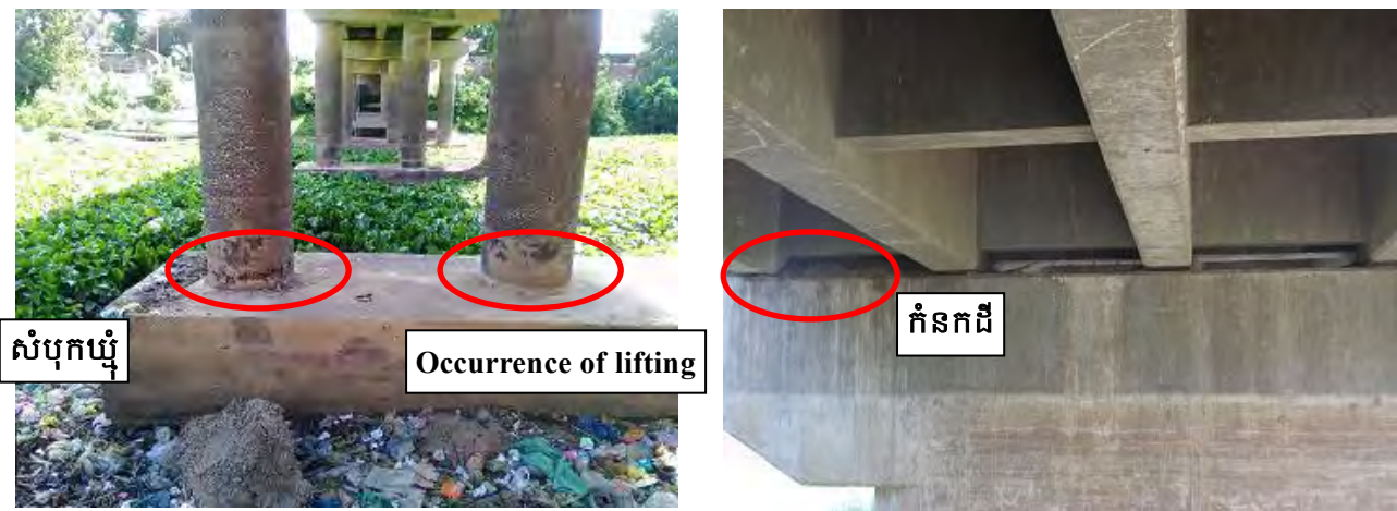
រូបថត ៣.៨.៦ ចំនុចត្រូវត្រួតពិនិត្យលើសរសរស្ពាន
