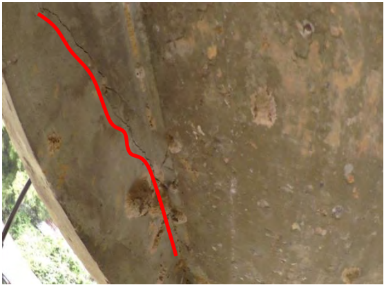
)គការខូចខាតគ្រឿងបង្កើនធ្ងន់ធ្ងរលើ (ផ្ទឹមបេតុង (Shearing crack)
