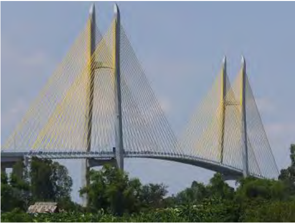
រូបថត ១.៤.៦ ស្ពានខ្សែកាប Cable stayed bridge (ស្ពាន Tsubasa)
