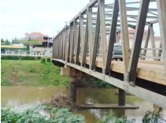
រូបថត ១.៤.៧ ស្ពានដែកខ្វែង Truss bridge
