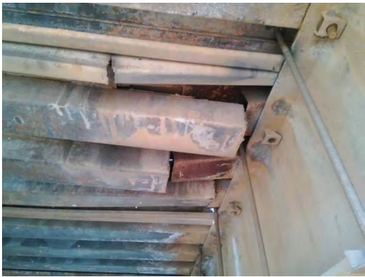
)ឃការខូចខាតគ្រឿងបង្កើនធ្ងន់ធ្ងរលើ (កំរាលស្ពានដែក (Fatigue crack)
