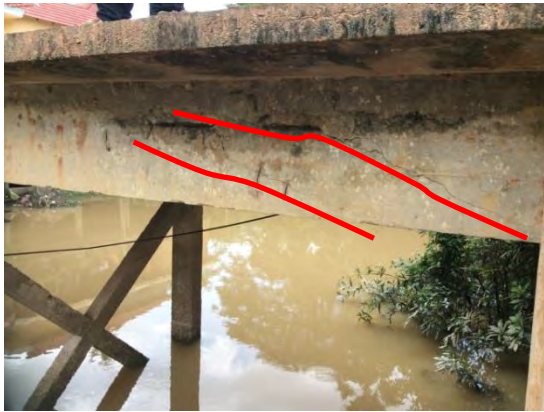
)គការខូចខាតគ្រឿងបង្កើនធ្ងន់ធ្ងរលើ (ផ្ទឹមបេតុង (Shearing crack)
