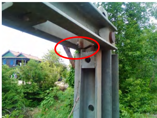
)ង (ការខូចខាតគ្រឿងបង្កើនធ្ងន់ធ្ងរលើផ្ទឹមមេ ឬផ្ទឹមខ្វែង (Fatigue crack)
