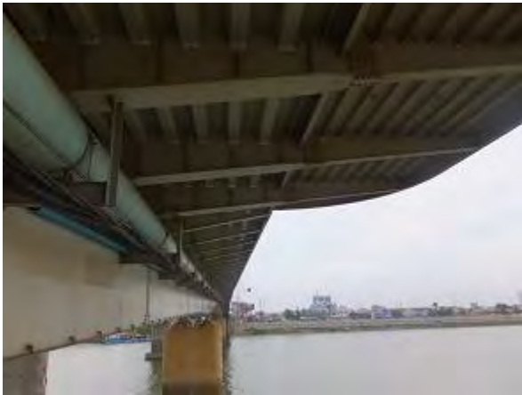
រូបថត ៣.៨.៩ បន្ទះដែក Orthotropic deck plate (ស្ពាយជ្រោយចង្វា)
