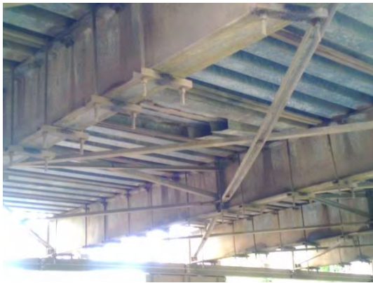
)ឃការខូចខាតគ្រឿងបង្កើនធ្ងន់ធ្ងរលើ (កំរាលស្ពានដែក (Fatigue crack)
