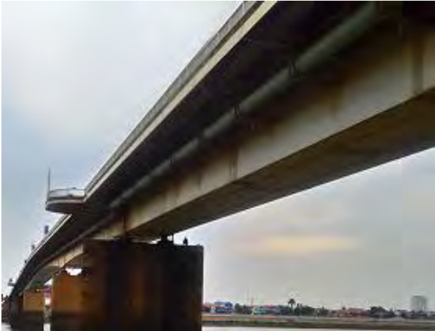
រូបថត ១.៤.៣ ស្ពានធ្នឹមប្រអប់ Box girder bridge
