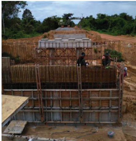
Sta. 2+650 L=30m, W=8m
