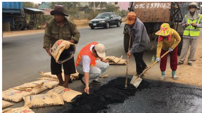
(道路補修パイロットプロジェクトの様子)
