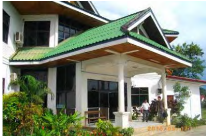
Sekong 県 PAFO 事務所
