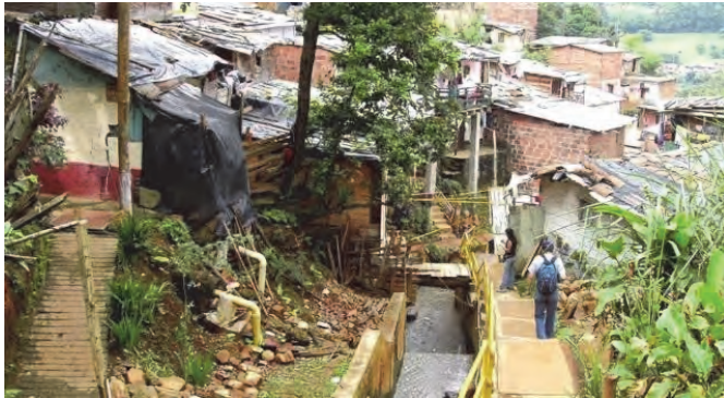
整備前のファンボボ地区
