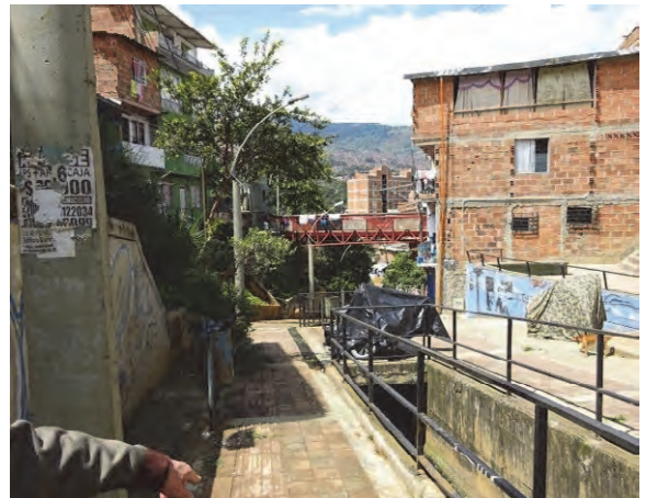
奥に見える橋は、溪流兩岸の住民を分断しないように設置されたもの
