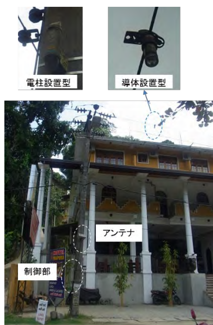
図 9-9 架空配電線用の事故電流表示器（導体設置型・電柱設置型）
