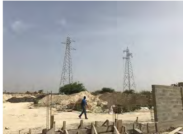
Sendou 火力発電所構外の 225kV 鉄塔の様子
