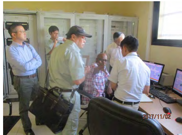
クヌーヌ変電所の様子
