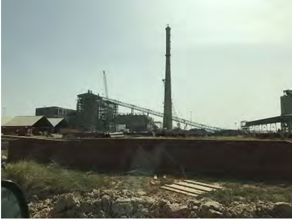
Sendou 火力発電所建設中の様子
