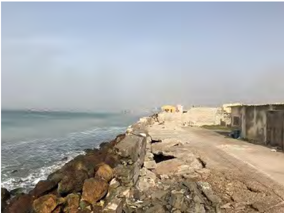
Bargny 港建設予定地の様子
