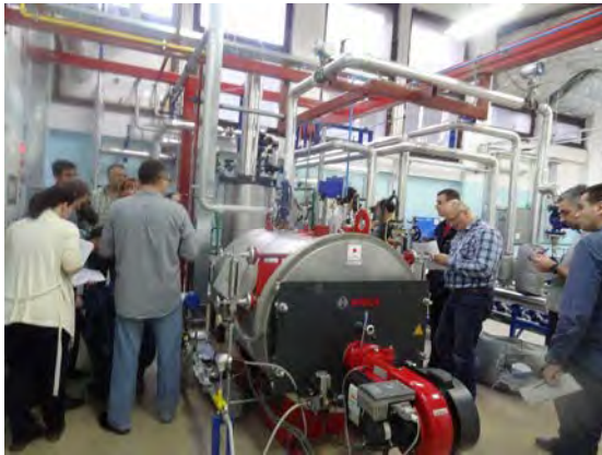
ボイラーの実技研修
