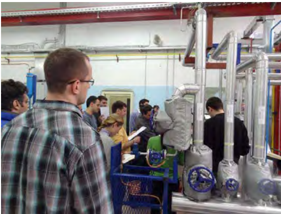
ボイラでの実習状況
