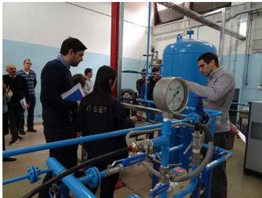
ポンプの実習状況
