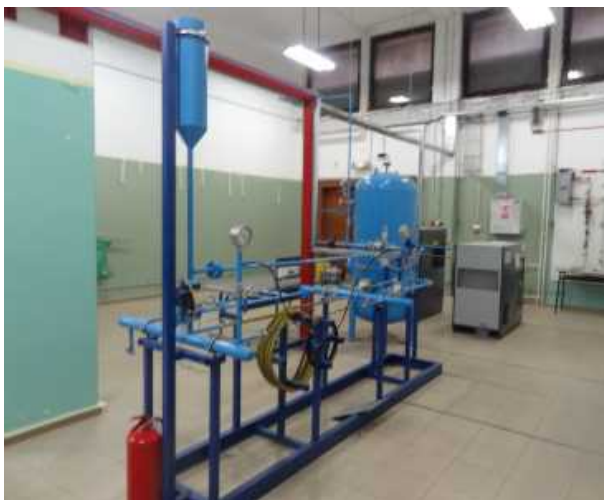
エアコンプレッサーユニット
