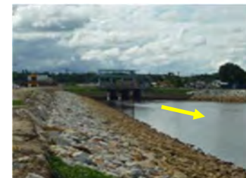
排水路と樋門
