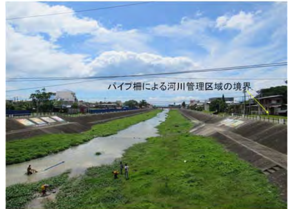
アニラオ川の中下流区間における河川改修
