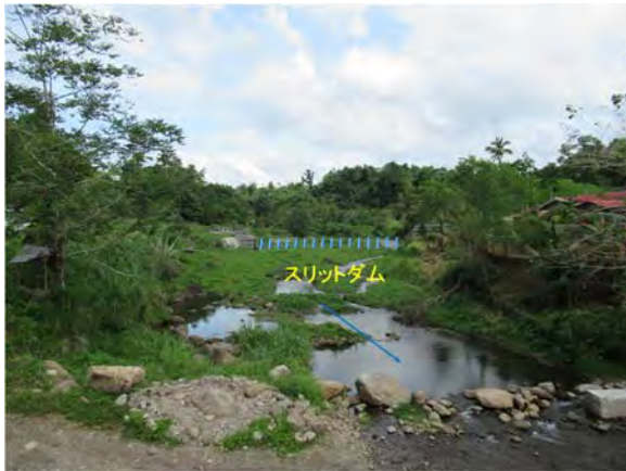
アニラオ (Anilao) 川上流区間におけるスリットダム
