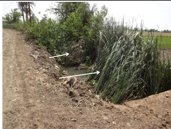
図 4.52 ファイユームのメスカの状況 （道路法崩れによる水路内の通水阻害）
