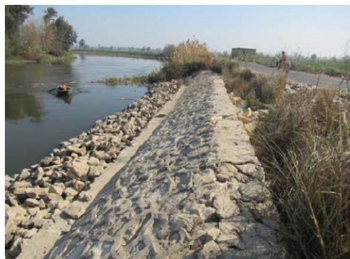
MWRI が建設した護岸工（El Gafadon 村付近）
