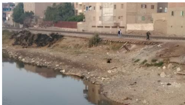
イブラヒミア基幹水路沿いの鉄道敷きの崩壊
