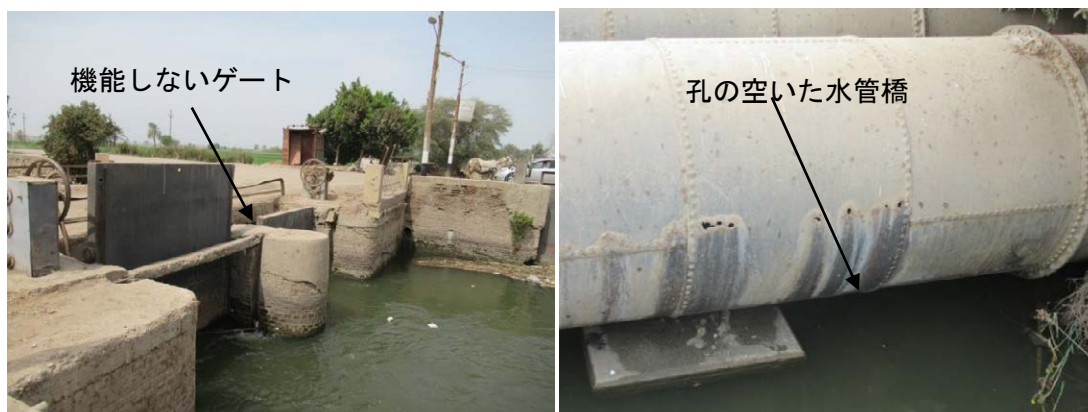
図 4.42 老朽化した水利施設（調整堰、水管橋）
