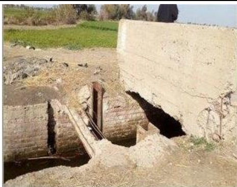
図 4.48 ダマト支線ナガ水路分水工 （ゲート欠損）
