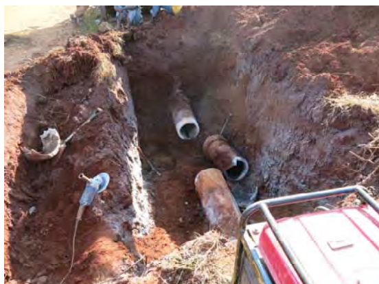
LWB 作業状況（漏水対策工事） リロングウェ南部地域（2017/7/26）
