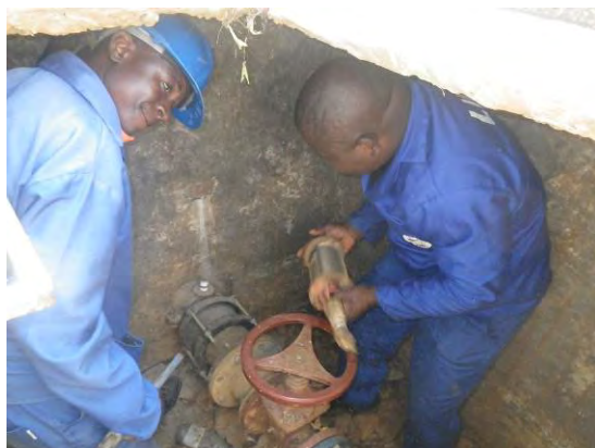
LWB 作業状況（水圧計交換工事） リロングウェ南部地域（2017/7/27）
