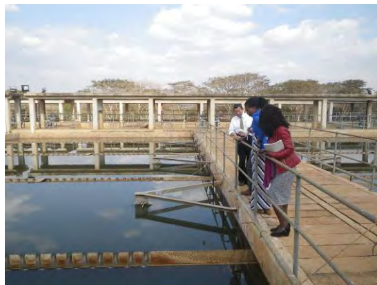
LWB 既存施設 (浄水場) LWB 浄水場 (2017/7/18)
