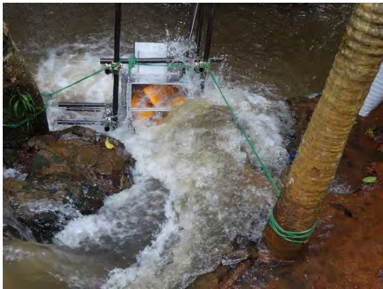
設置されたマイクロ水力発電機
