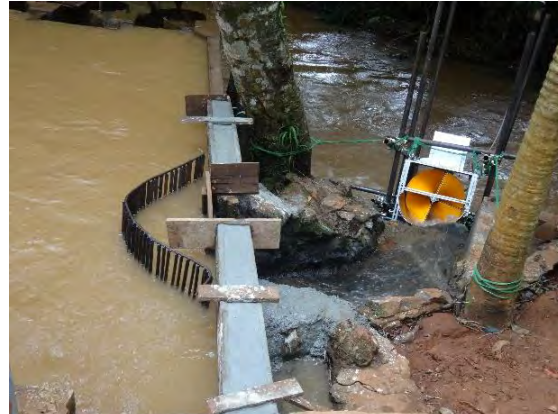
オロミスによるゴミ防止工事
