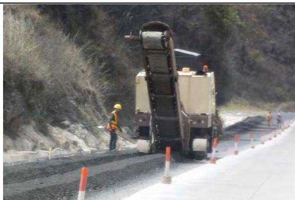
CA-5S 道路改修工事路上再生路盤
