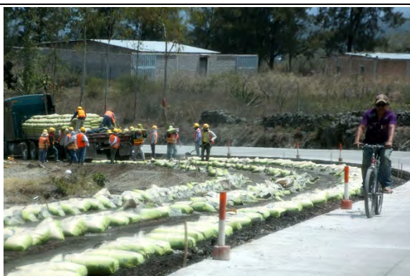
CA-5S 道路改修工事セメント安定処理
