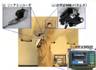
図-2 鋼床版 SAUT 探傷状況
