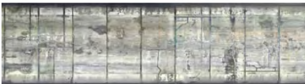
トンネル内空点検例
