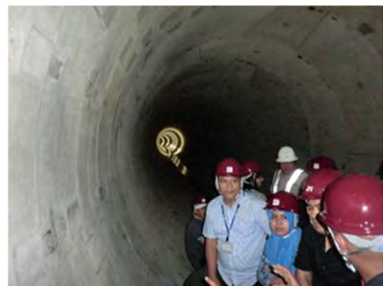
シールド工法による管渠布設工事現場視察 （2016年9月1日）
