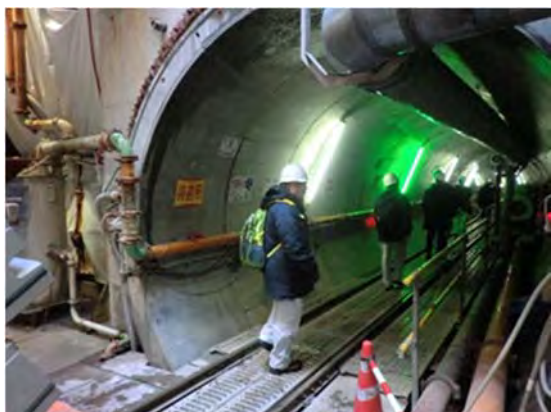
シールド工法による管渠布設工事現場視察 (2016年2月25日)
