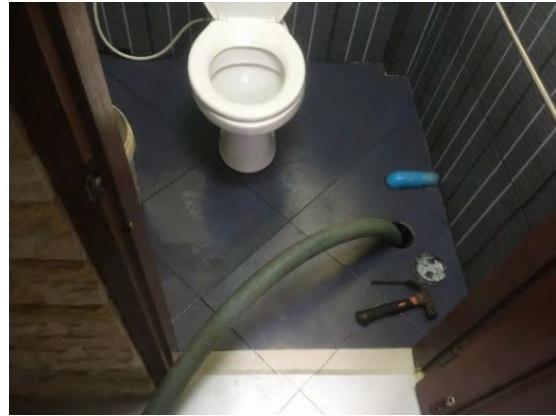
家庭の腐敗槽からの引抜
