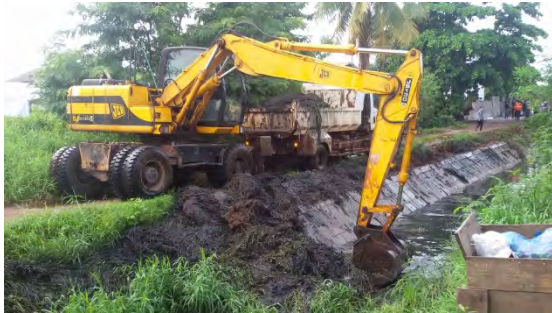
バックホーによる底泥除去
