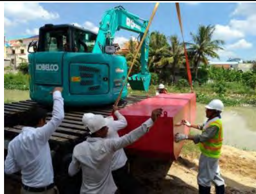
フロート取り付け作業 (2017. 06. 27)
