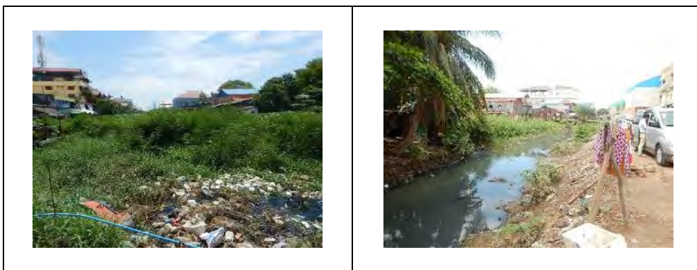
写真 3-11 その他排水路①、区画①と②の現場写真
