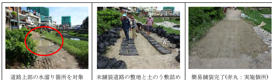
写真 3-8 土のう工法における道路の簡易舗装
