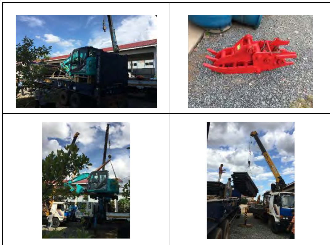
写真 3-2 機材の荷下ろし、検品状況
