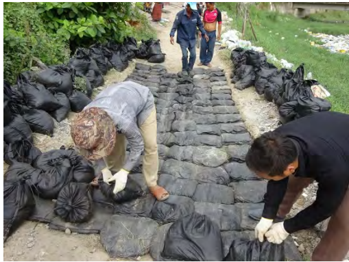
浚渫汚泥による道路化に舗装の状況(1) (2017. 11. 30)
