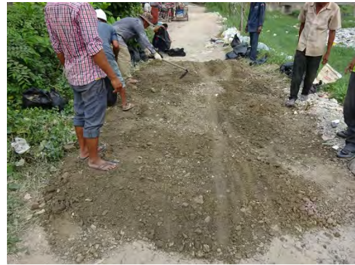
浚渫汚泥による道路化に舗装の状況(2) (2017. 11. 30)
