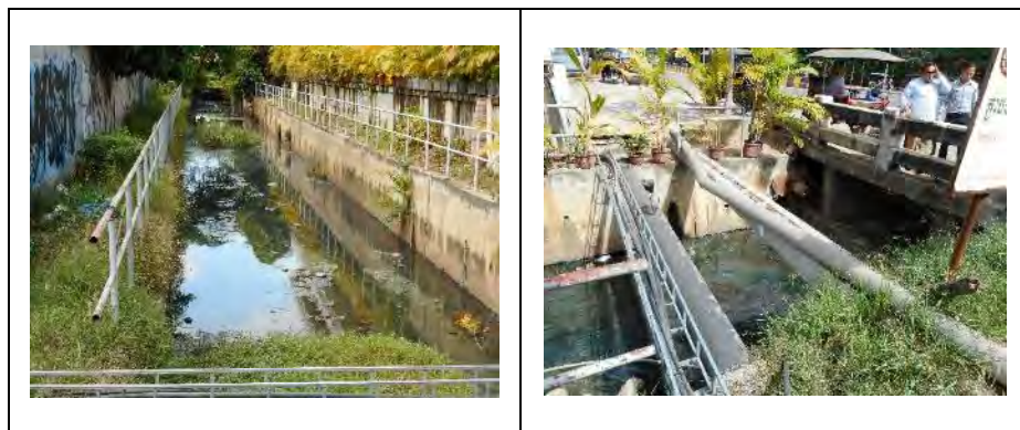
写真 3-16 排水路①の現場写真
