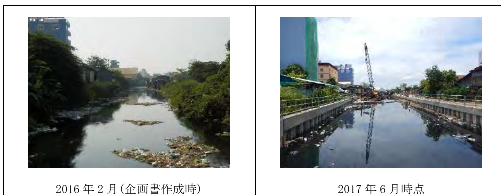
写真 3-6 Trabek 排水路における護岸整備状況
