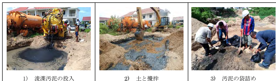
写真 3-7 土のうの作成状況
