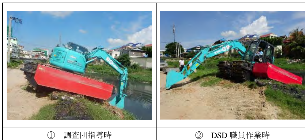
写真 3-4 排水路への侵入方法
