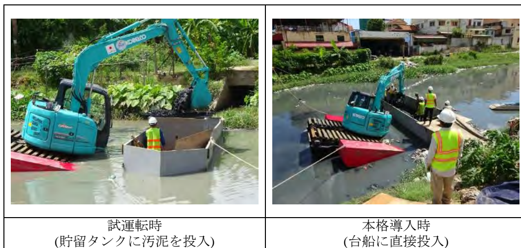
写真 3-3 排水路への底泥浚渫作業
