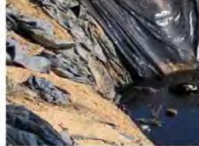
セフロ・プロバンス:小規模伝統プレス工場のマルジン池。環境局の指導により建設したものの、薄いビニールを敷いただけのため、土壌浸出が認められる。
