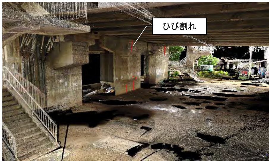
図 3.19 KUMONOS と 3D レーザースキャナの組み合わせ結果
