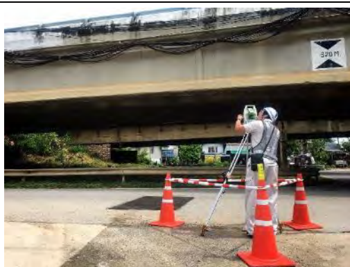
パイロット計測
