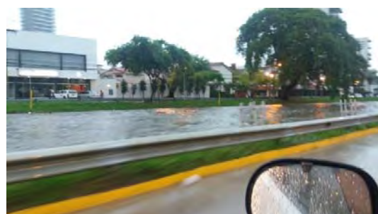
Debido a la limitada capacidad de drenaje
