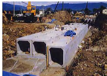
Construcción del canal con cámara box culvert por debajo de Terrenos Públicos
