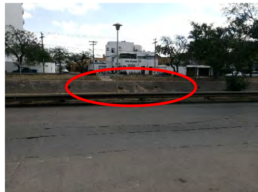
Salida del Drenaje de la Tubería
