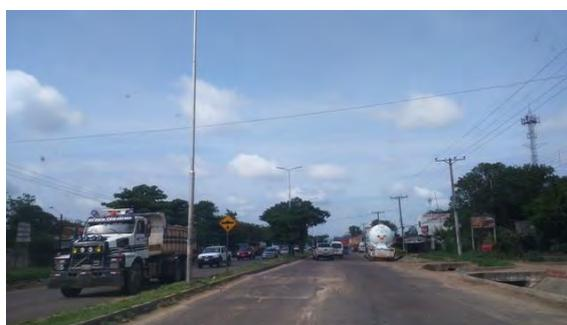
La carretera en general es de doble calzada con dos carriles por sentido, en algunos sectores está deteriorada a causa de la carga pesada
