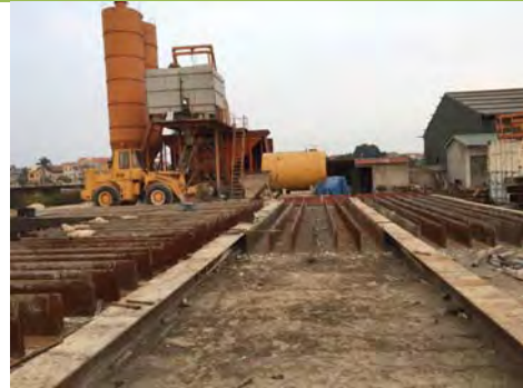
写真-14 : RETAQ センター建設用杭工場 (2017年12月)
