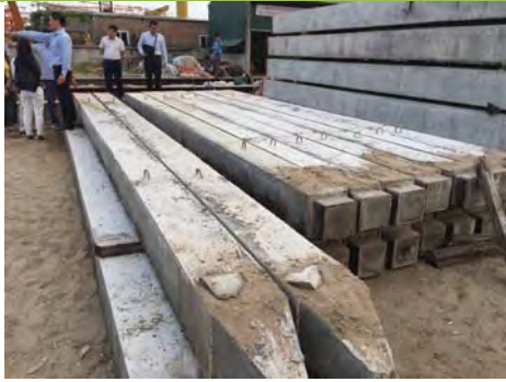
写真-13 : RETAQ センター建設用杭工場 (2017年12月)
