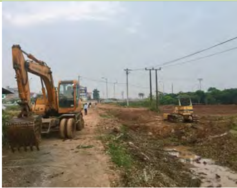
写真-9 : RETAQ センター建設予定地 (2017年12月)
