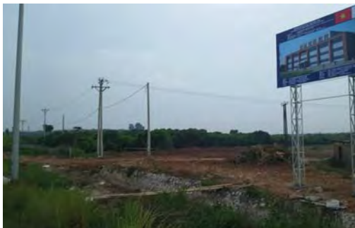
写真-11 : RETAQ センター建設予定地 整地・工事看板設置 (2017年12月)
