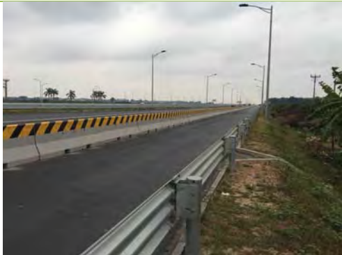
写真-5 : RETAQ センター建設地前の高速道路。(写真1と同じ場所 2017年7月)
