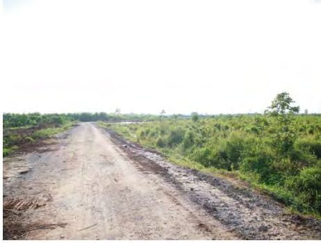
写真-1 : RETAQ センター建設予定地 道路建設が行われている。道路工事が始まっている (2013年12月)。右側が建設予定地
