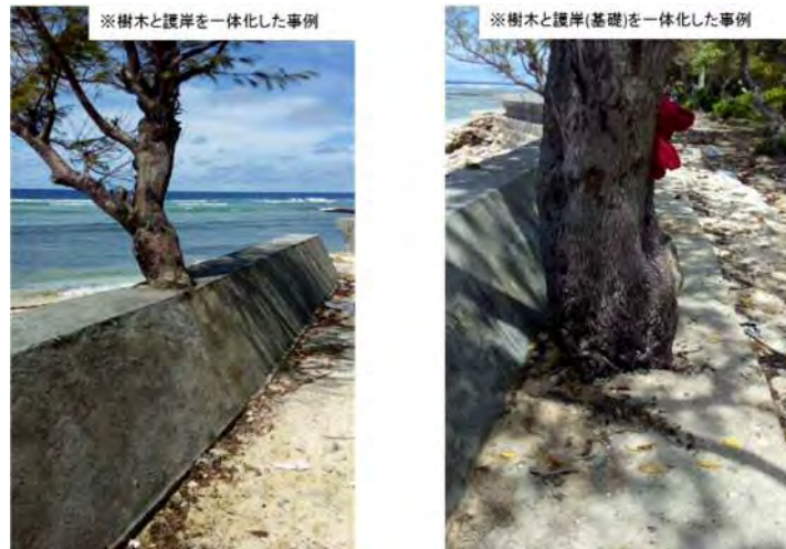
写真－1 標準図1枚で施工された事例(護岸や基礎との一体化)
