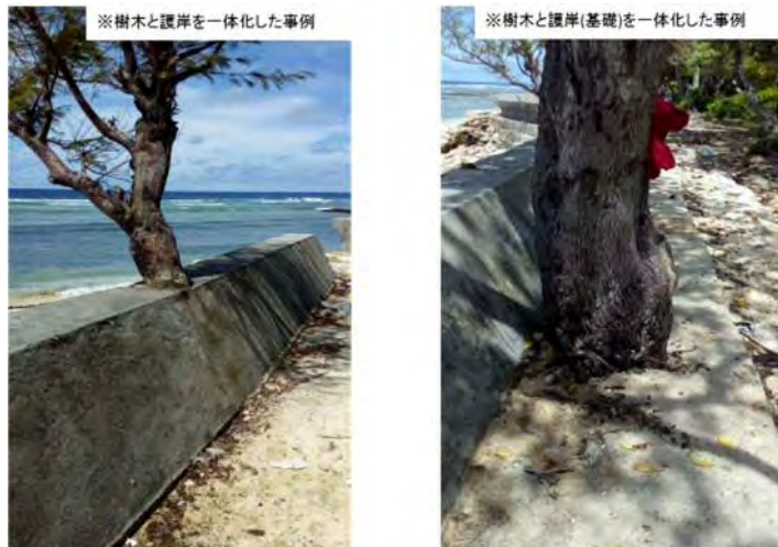
写真3-6 標準図1枚で施工された事例(護岸や基礎との一体化)
