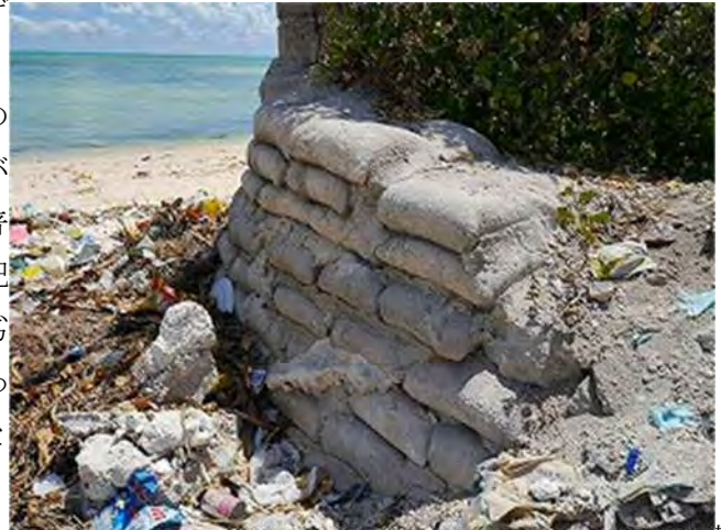
写真5-1 サンドバック工法の護岸
