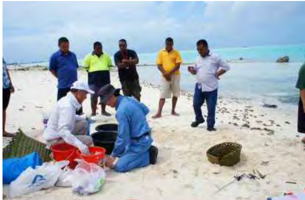
現地骨材を利用したHDGコンクリート作製
