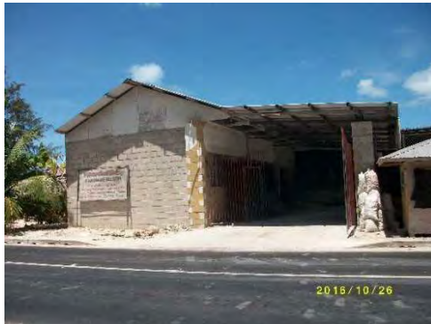
写真3-5 建物の状況（コンクリートブロック、RC 造の建物）
