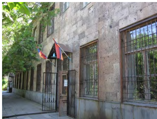
写真-2: 新しく修復ラボラトリーが設置される建物
