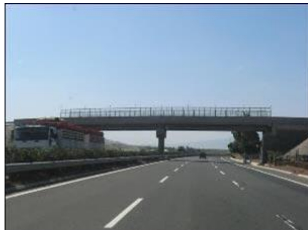
Chaussée et passage supérieur
