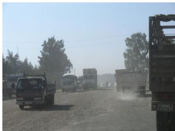
Route détériorée sur le corridor de Djibouti (Ethiopie)
