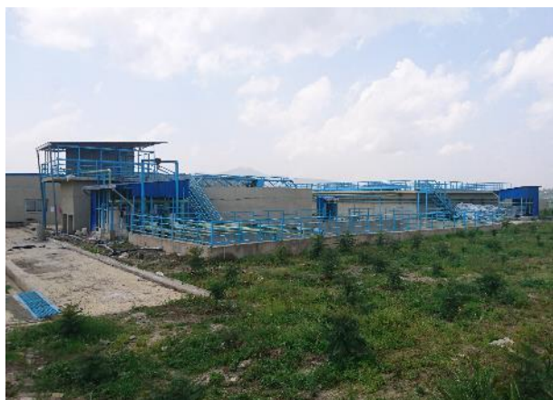
Installation de traitement de l'eau, parc industriel Bole Lemi, Ethiopie
