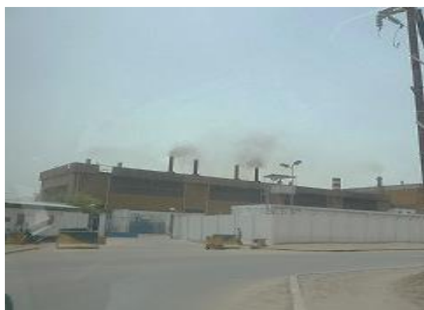
Centrale électrique de Boulaos (15 générateurs diesel), Djibouti
