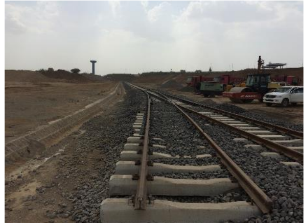
Modjo Dry Port Construction de chemin de fer, Éthiopie
