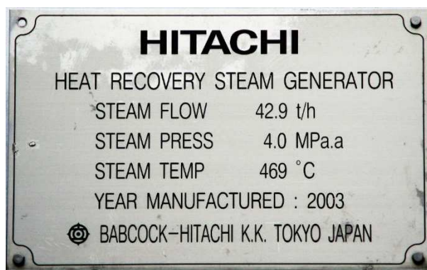
Figure 3.4.2-4 HRSG Nameplate Photo in Ywama Power Station
