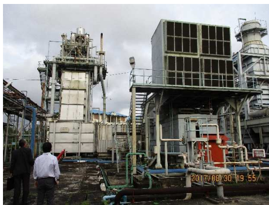
Figure 7.3-1 Photo of Ywama's Gas Turbine and HRSG
