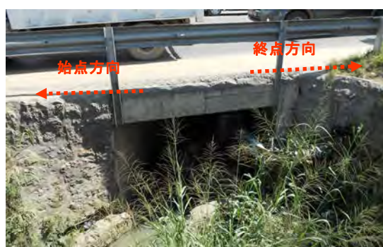
既設横断カルバート (2.4km 付近)
