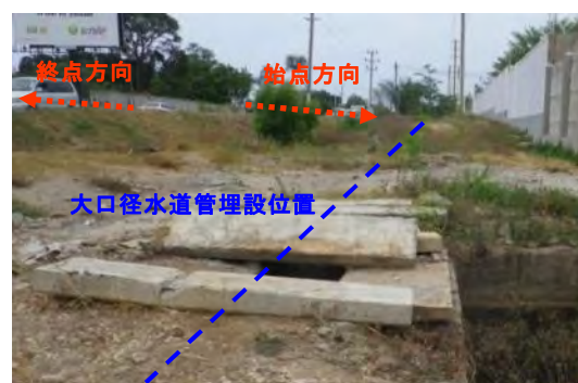
支障物-既設水道管 (0.2km 付近、道路左側)
