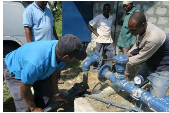
写真 3-15 井戸周り配管の修繕
