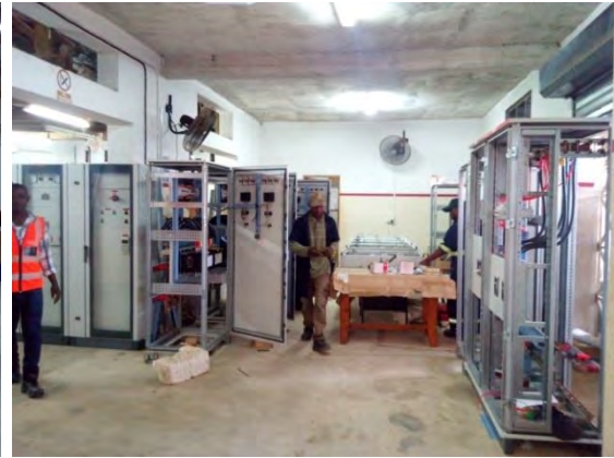
写真 3-19 ポンプ操作盤の組み立て工場
