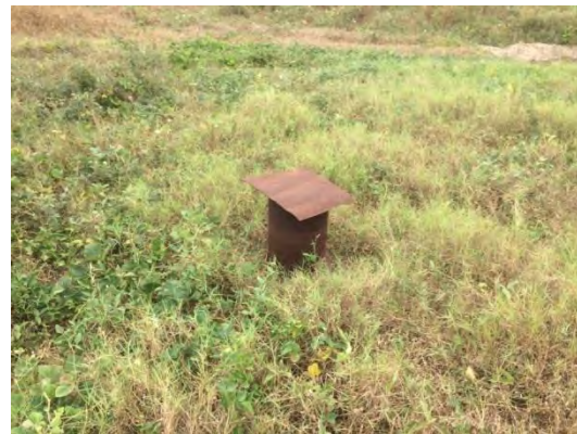
写真 4-2 井戸掘削プロジェクトによる 開発井戸 (ポンプ未設置)
