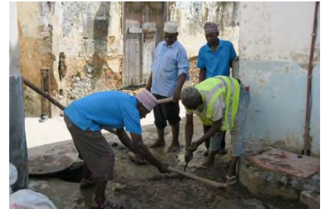
写真 3-23 漏水修理状況
