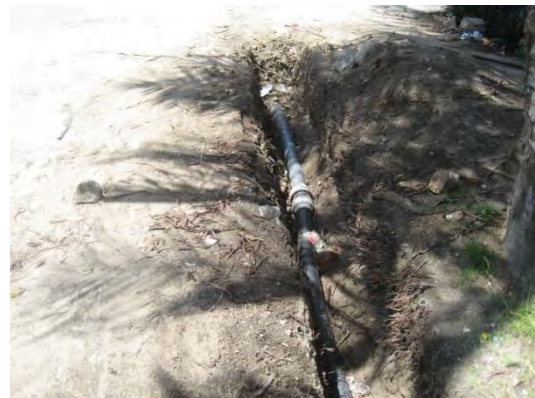
写真 3-4 浅い土被りでの配管布設
