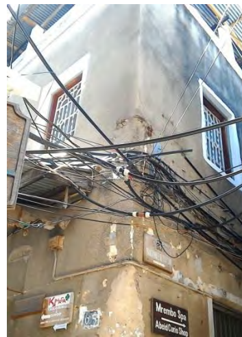
写真 2-2 非公式供給者の露出配管 (2)
