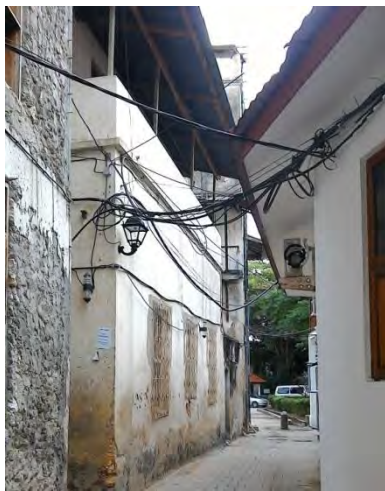
写真 2-1 非公式供給者の露出配管 (1)
