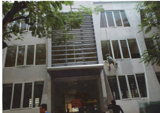
完成間近のゴム研究センター
