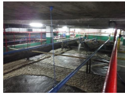
ホテルCの浄化槽内部
