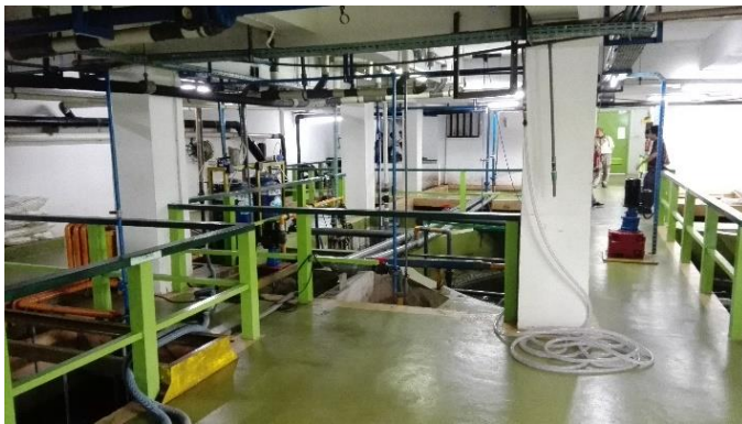
ホテルDの浄化槽内部
