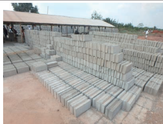
12. コンクリートブロック保管状況
