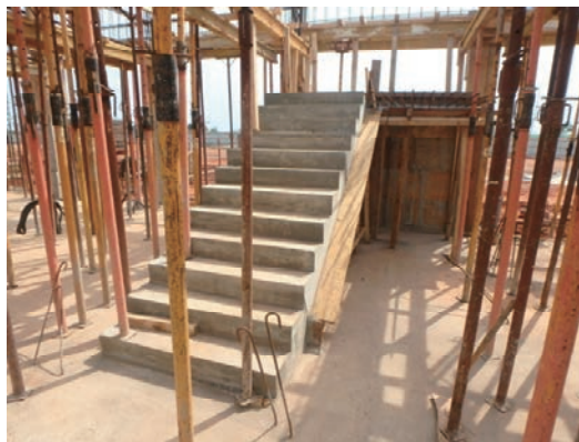
9. 階段施工状況
