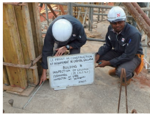
8. 柱型枠建込み検査状況
