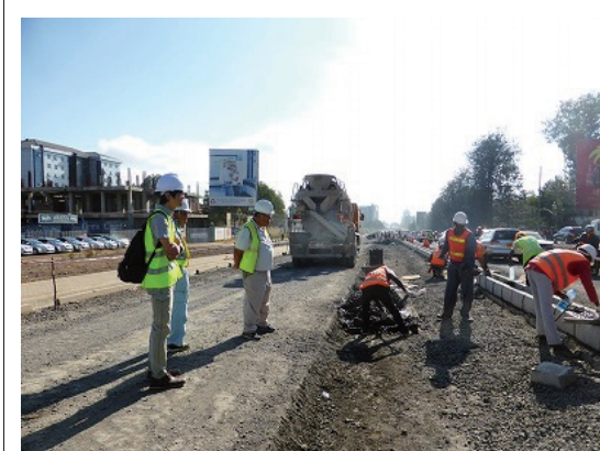
9 中央分離帯の工事状況
