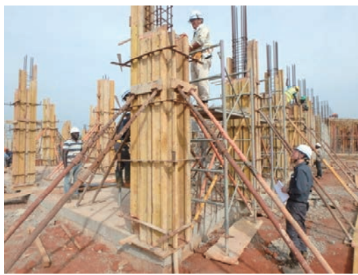
7. 柱型枠建入れ確認状況
