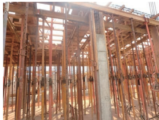
10. 屋上床梁施工状況
