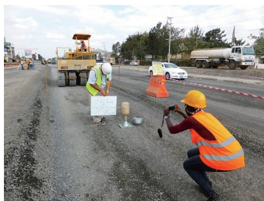
17 現場密度試験への立会い検査の状況
