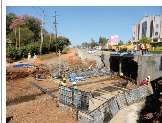
11 ボックスカルバートの工事状況
