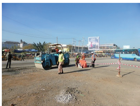
2 路盤工事の状況
