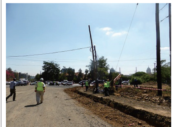
14 シティモーチュアリー交差点付近における支障物件（電柱）の移設工事の状況
