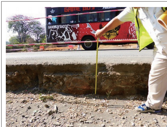
10 現道下の既存路盤
