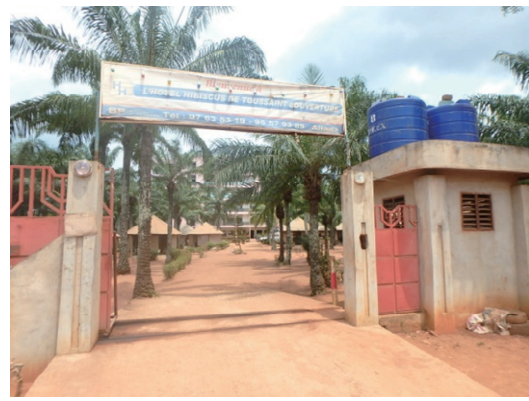
28. 監理事務所及び作業所兼宿舍入り口 現場から車で5分ほどのホテル施設の一部が借り上げられ、 監理事務所及び作業所、宿舍が設けられている。
