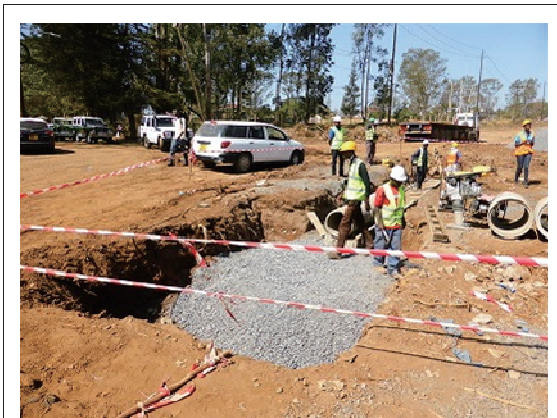
13 道路横断管の敷設状況
