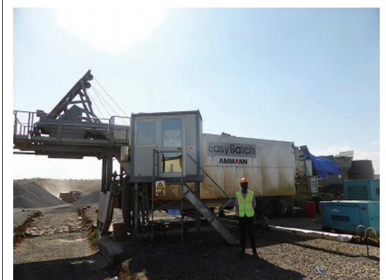
21 アスファルトプラントの設置状況
