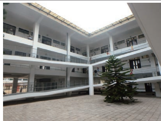
30. ラグューン母子病院(2009年竣工) ODAで実施された既存病院において、左記の3者参加のもと、 施設の品質及び仕上がり具合、建具金物実態調査が行われた。 (2016年8月23日実施)
