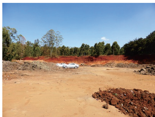
18 土捨て場の状況
