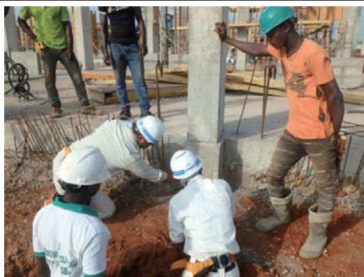
11. コンクリート補修指導状況
