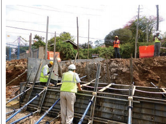
12 コンクリート擁壁の型枠設置検査
