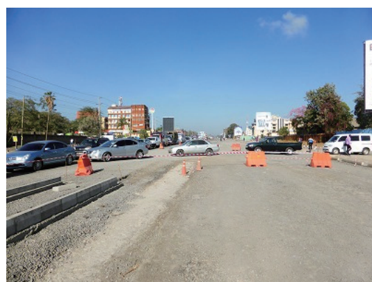
5 交差点におけるバリケードの設置状況
