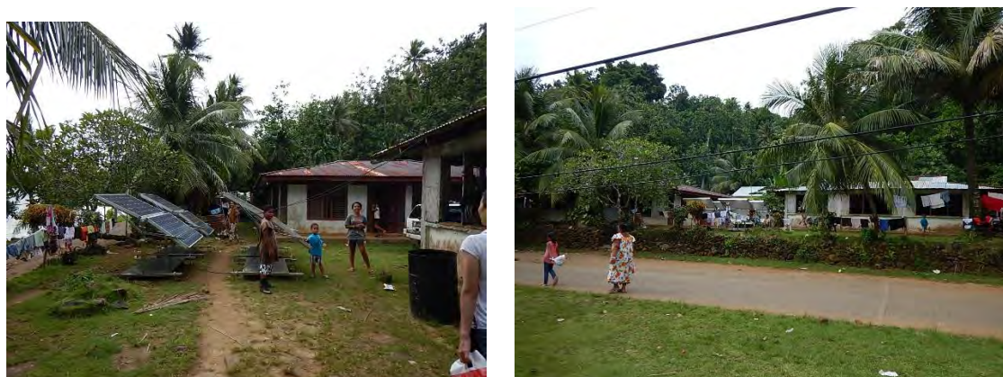
図 3.18 第4回現地調査時における太陽光発電パネルの屋外設置状況
