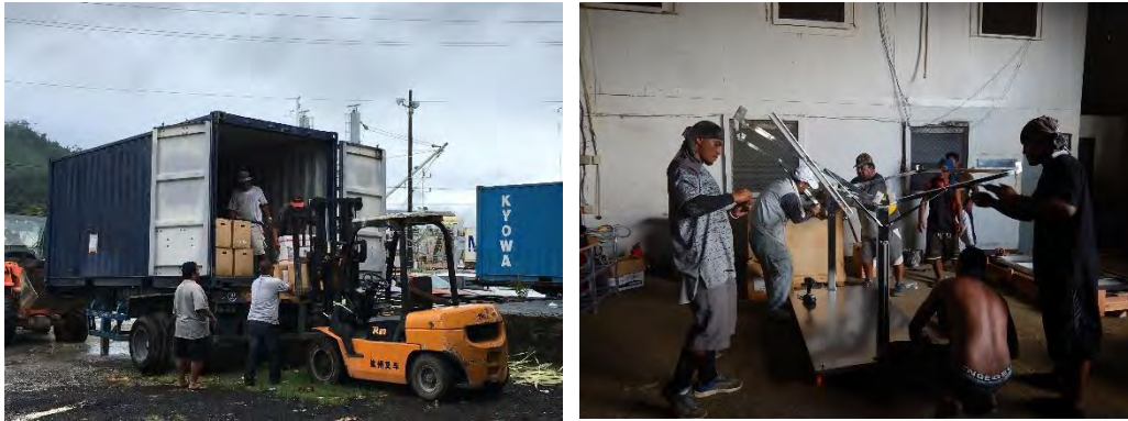
図 3.7 コンテナからの機材取り出しと太陽光発電パネルユニット組み立ての様子
