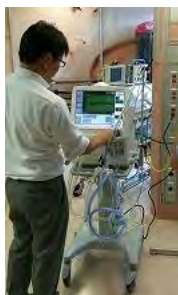
機材の設置・現地適合性確認 (2017年7月6日)
