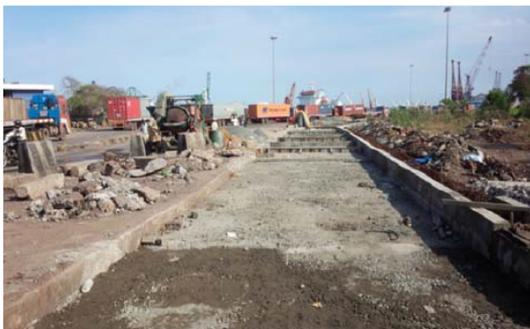
構内の交通流整流化は大きな課題である。構内道路の改良等の提案する一方、ChPTでは混雑緩和のため、順次道路の改良・拡幅などが進められ、新たなルート of 整備や車線の明確な分離なども並行して行われている。引き続きの努力が必要である。
