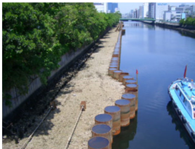
写真 14-5 鋼管矢板工法の護岸への適用事例
