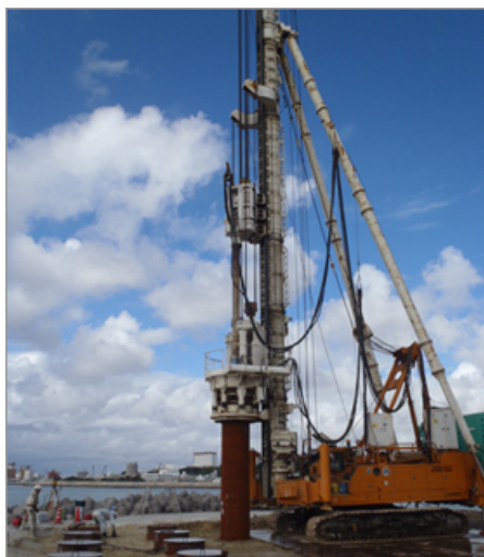
写真 14-4 鋼管杭打設工事の事例
