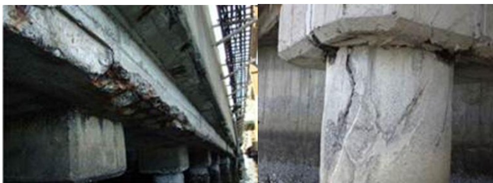
写真 14-100 鉄筋の腐食により機能低下したコンクリート構造物
