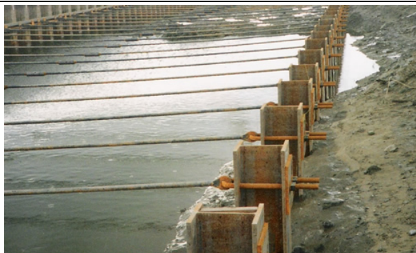
写真 14-9 タイロッドとアンカー
