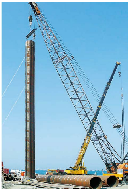
写真 14-6 鋼管杭の打設
