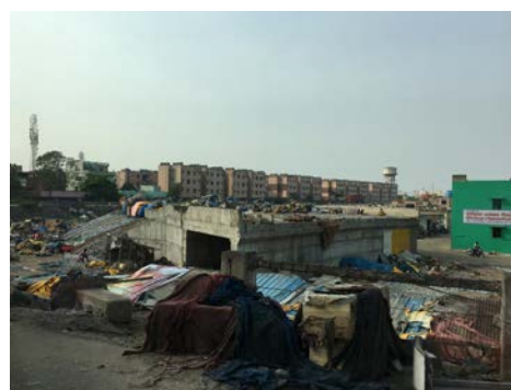
図 3-16 州道 114 号及びアクセス道路の改良状況
