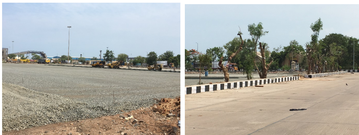
写真 3-3 ONB エリアの舗装工事と植栽
