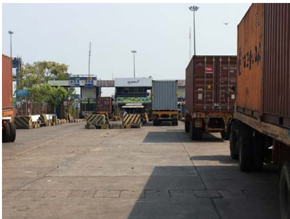
写真 3-4 DPW インゲート前の改善
