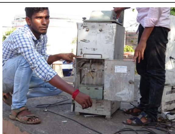
写真 3-18 NO 2 、SO 2 監視機器 (地点 A4 :消防署)
