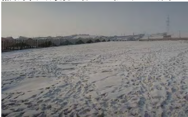
建設用地。かなりの勾配がある。
