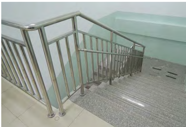
59 番学校 (小学校幼稚園統合校): 階段の二段手摺。・
