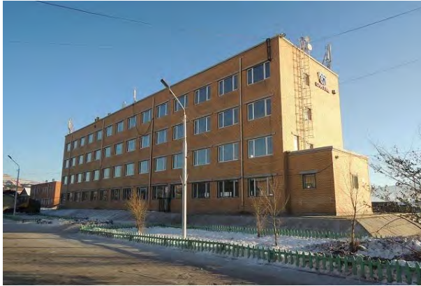
87 番学校(無償 3 次): 伝統的なレンガ外壁。
