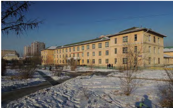
既存校舎正面。空港へ向かう幹線に面する。
