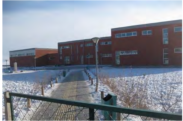
125 番学校：歩道には点字ブロックが設置されている。
