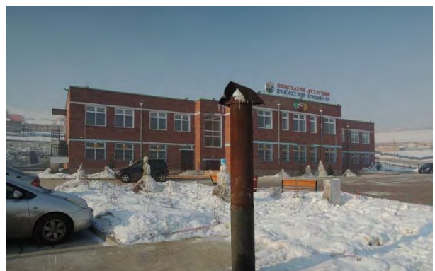
隣接する既存幼稚園園舎。約250人の園児がいる。
