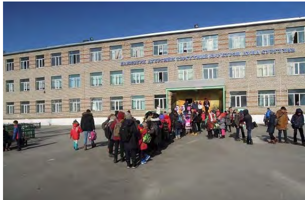
既存校舎正面。シフトの入替え時。
