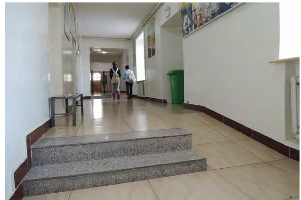
63 番特別学校: 廊下の床段差をスロープで解消している。
