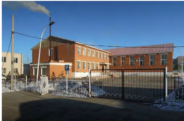
既存校舎正面。左手前が教室棟、右手奥が体育館。
