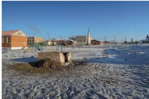
建設用地。緩い勾配がある。
