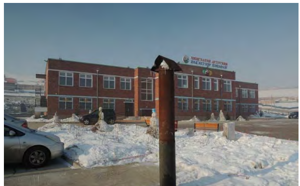
隣接する既存幼稚園園舎。約250人の園児がいる。
