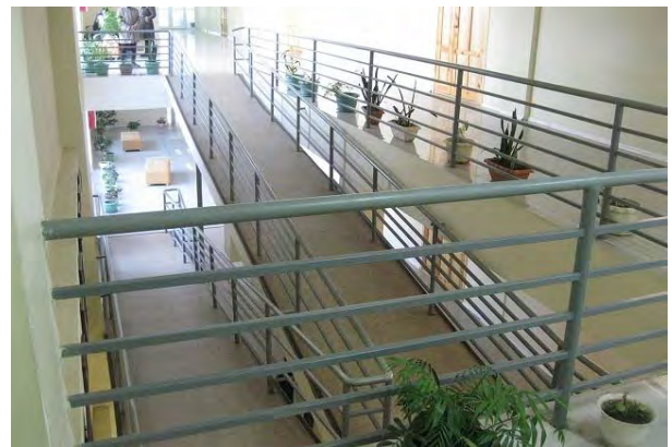
22 番学校: 1~3 階をつなぐスロープ。勾配がややきつい。
