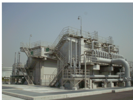
Figure 6.2-4 LNG Vaporizer (ORV)
