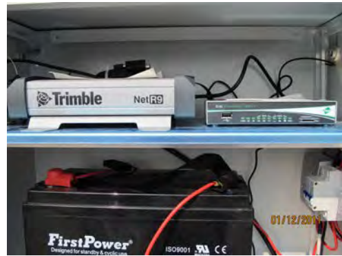
写真 6.3.4 電子基準点 (内部拡大) (受信機、送信機およびバッテリー)
