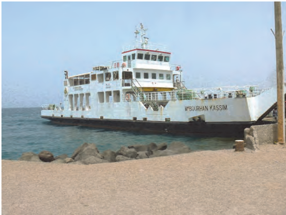
海事局所有のフェリー（2009年に無償資金協力にて整備） （右舷前方より：タジュラ港） 船体、甲板部、機関部は良好に維持管理されている。
