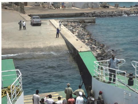
オボック港フェリー施設全景
