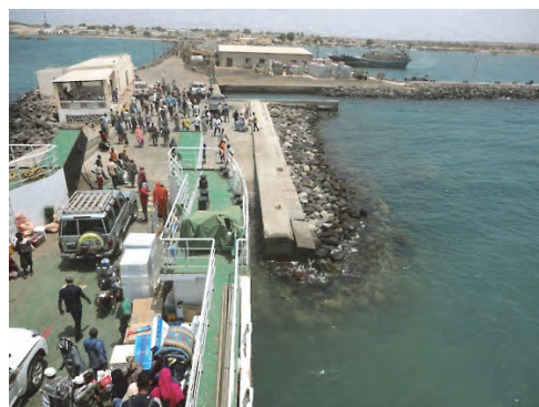
接岸の支障となる直立擁壁
