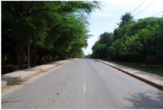
Situation de la route où la ligne de distribution sera mise en place (à proximité du poste de répartition de Sococim)
