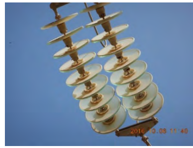
Figure 2-2-2-1-2.8 Poussière de ciment incrustée sur les isolateurs
