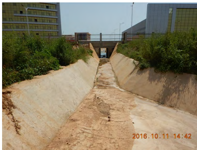
Figure 2-2-2-1-2.6 Voie d'eau existant sur le tracé Keyrhod et sur laquelle le pont réservé au câble sera mis en place
