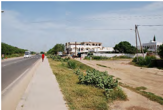
Situation de la route et des terrains d'habitation avoisinants (Bargny Kip)
