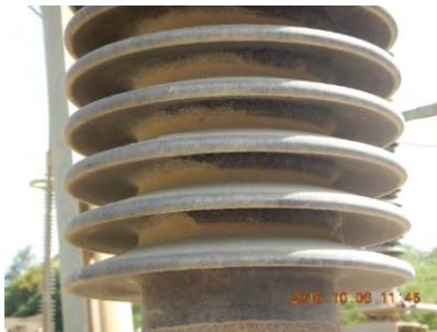
Figure 2-2-2-1-2.8 Poussière de ciment incrustée sur les isolateurs
