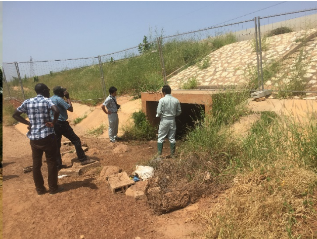
配電用ルート調査
