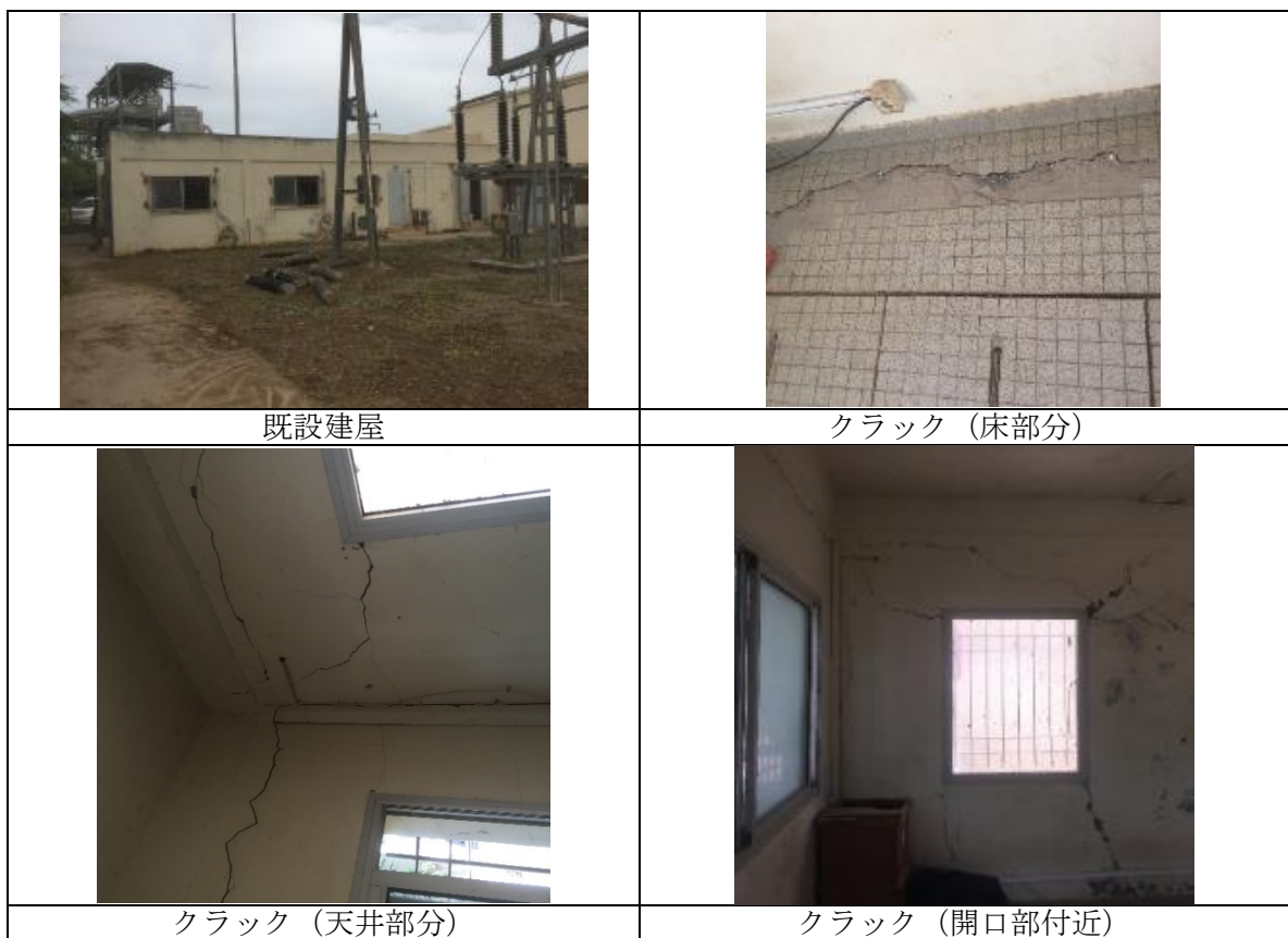
図 2-2-2.5 既設建屋の状況
