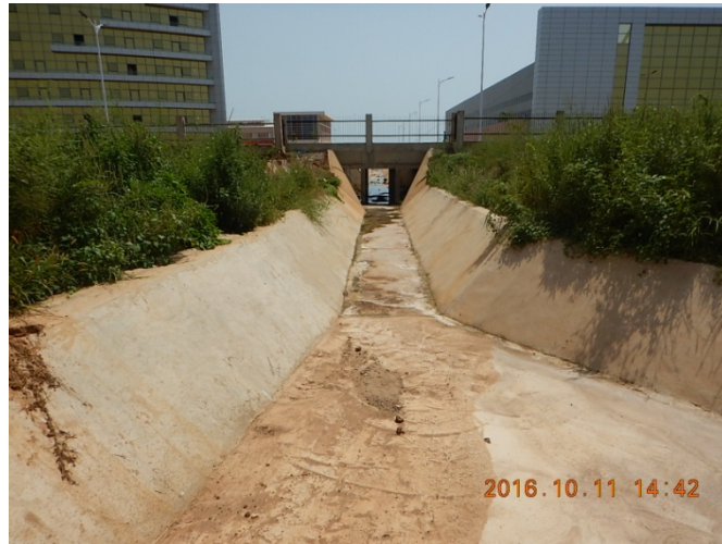
図 3-2-2-1-2.6 ケイロッドルート上のケーブル専用橋を架ける水路
