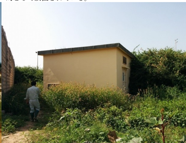
ペアージュ配電用変電所
