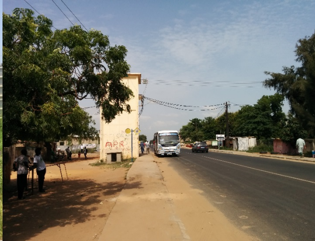
ケールダウダサール 配電用変電所
