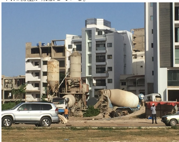
ダカル市内の建設工事現場
