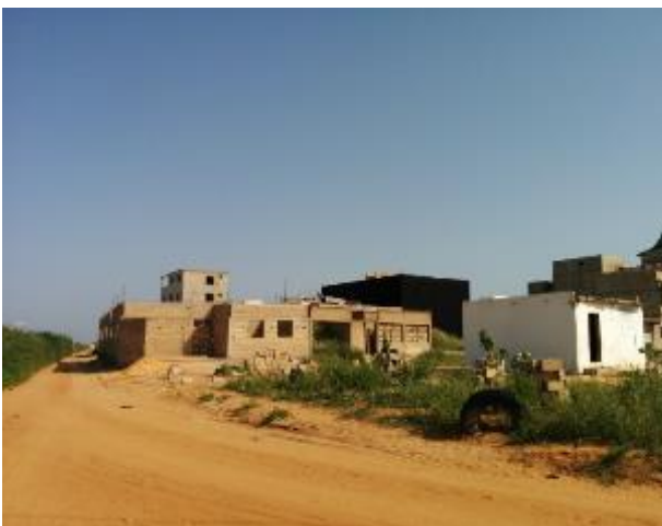
ペアージュ配電用変電所付近の住宅街
