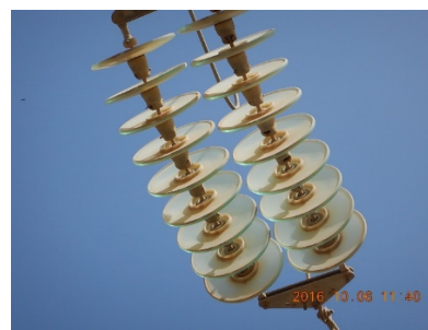
図 3-2-2-1-2.8 がいしに固着したセメント粉塵
