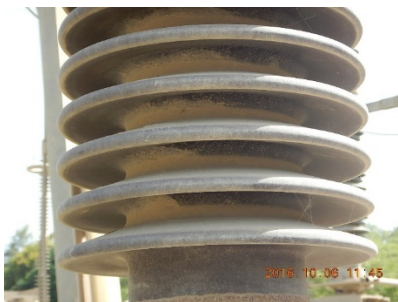
図 3-2-2-1-2.8 がいしに固着したセメント粉塵
