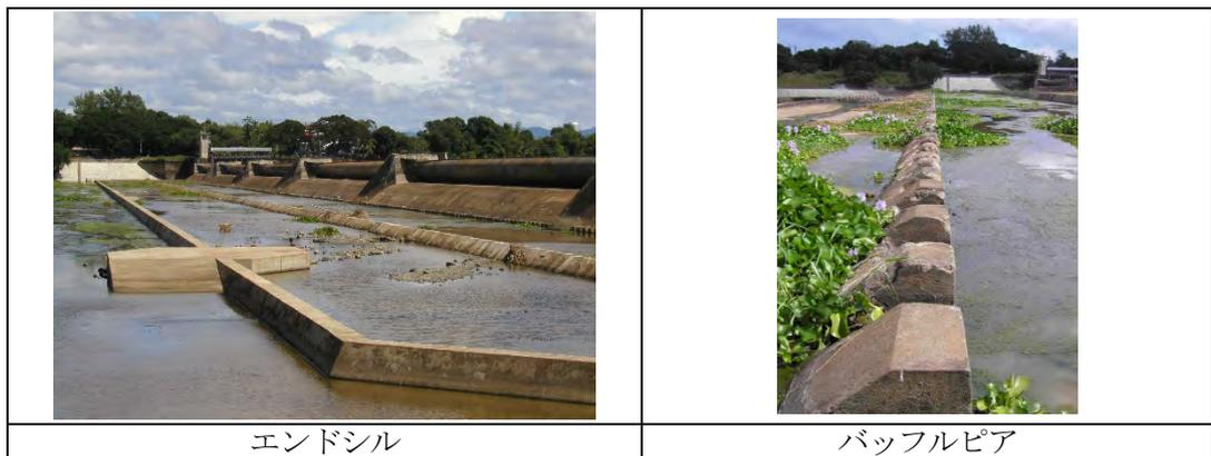
図 5.4.5 強制跳水のためのエンドシル・バップルピアの事例
