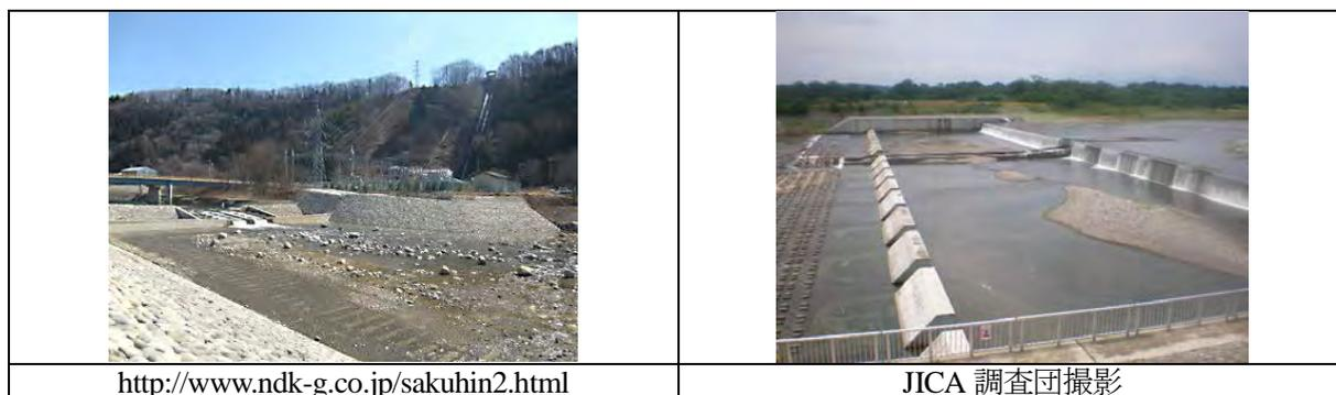
図 5.4.1 日本の落差工の事例
