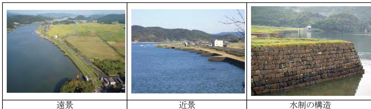
図 A.9 セグメント II の河川に 200 年以上前に設置された水制工 (川内川)
