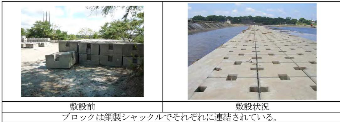
図 5.4.6 護床工に利用するコンクリートブロック事例
