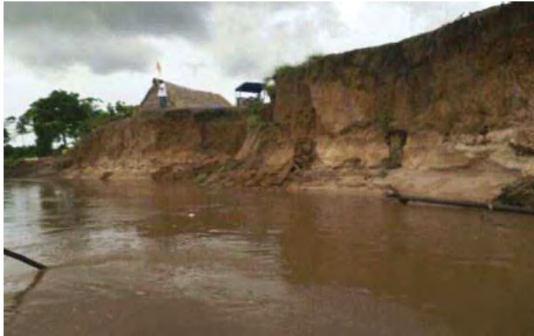
Otra vista de los deslizamientos que sufre la margen derecha del río Paranapura, tramo del área urbana del Caserío Santa Lucía.
