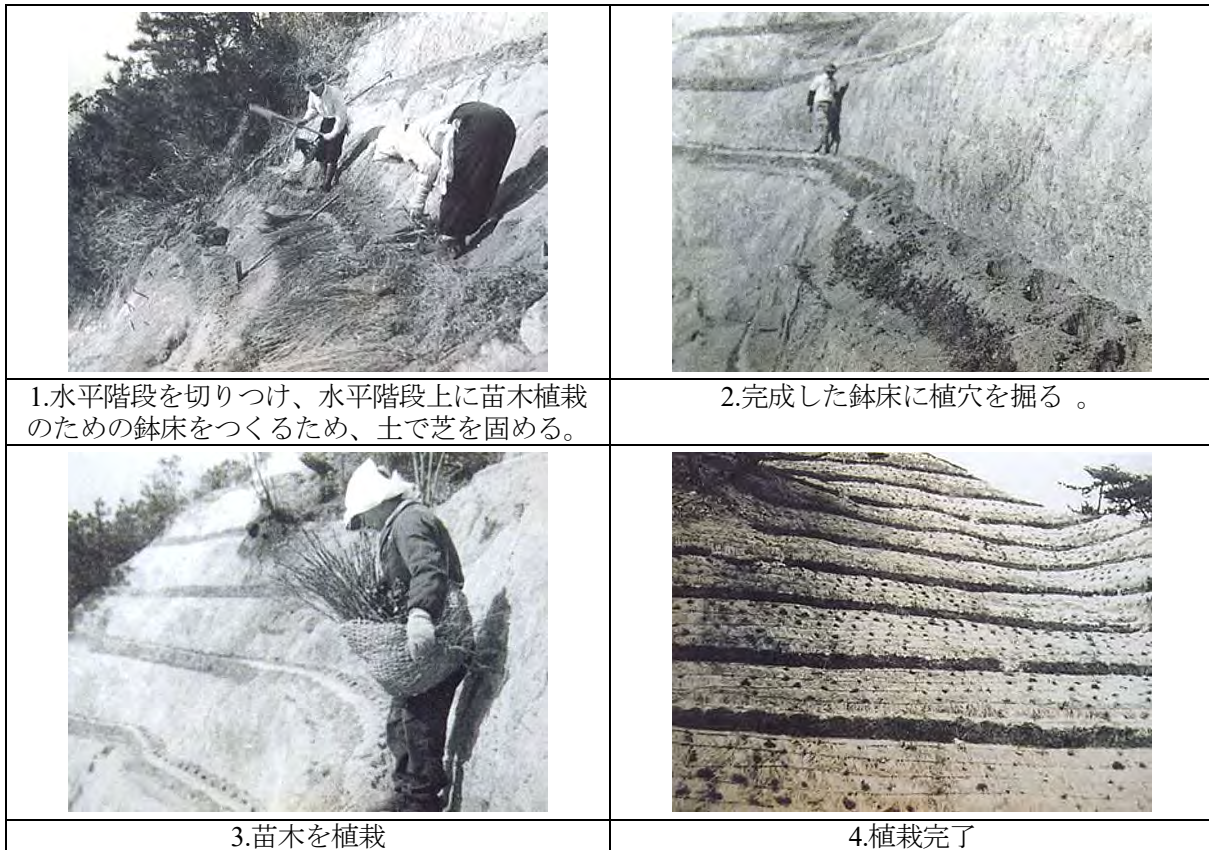
図 14.5.4 積苗工の施工状況（1954年）
