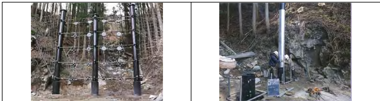
図 14.5.8 杭式土石流対策工「アーバンガード」（左：完成時、右：施工時）
