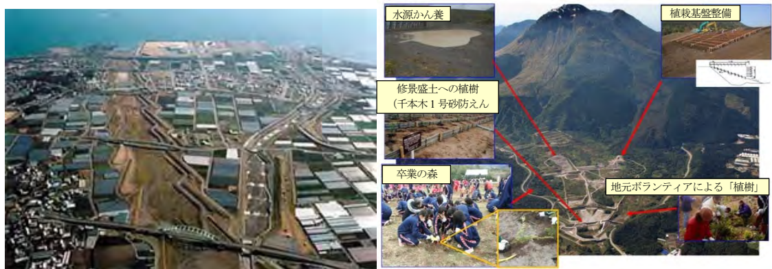
図 14.5.5 土石流対策工の例と雲仙における導流堤(左下)および樹林帯整備(右下)の例
