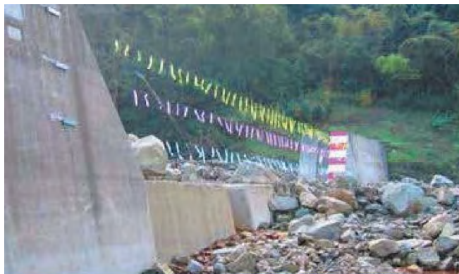
図 14.5.14 ワイヤセンサーの設置事例（水通し部に設置した例）
